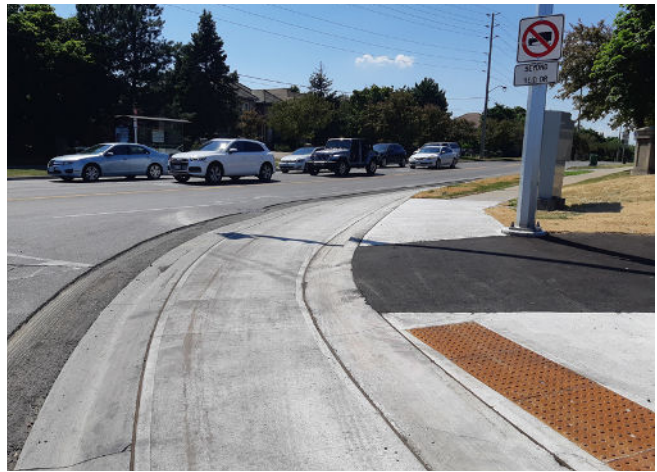
Traversable Curb (Mississauga, ON)
